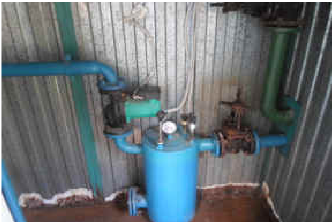
Видимое изображение №2 Обвязка насоса
