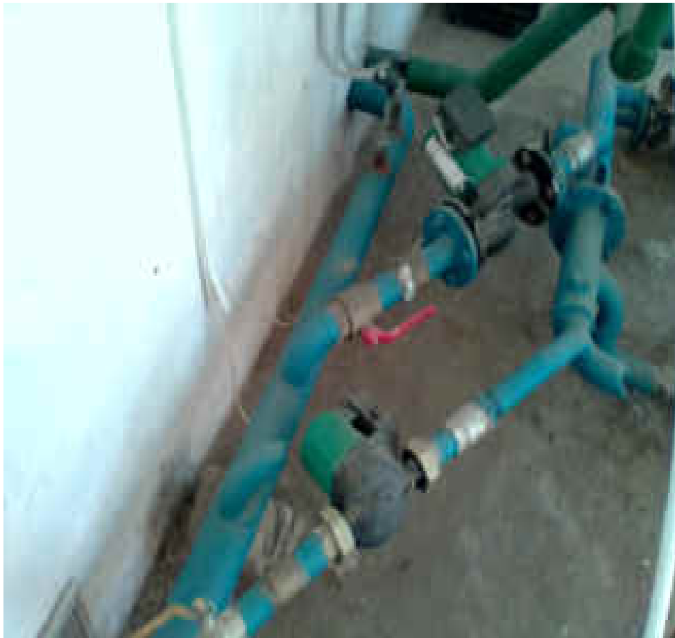
Видимое изображение №3 Трубопроводы обвязки котлоагрегатов
