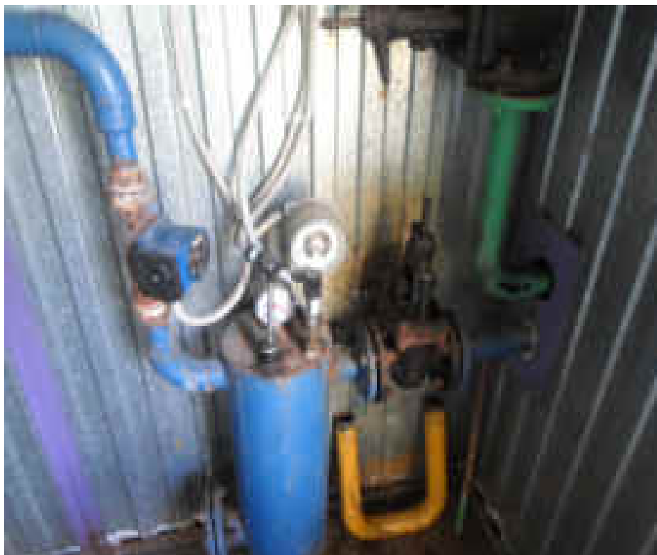
Видимое изображение №2 Обвязка насоса
